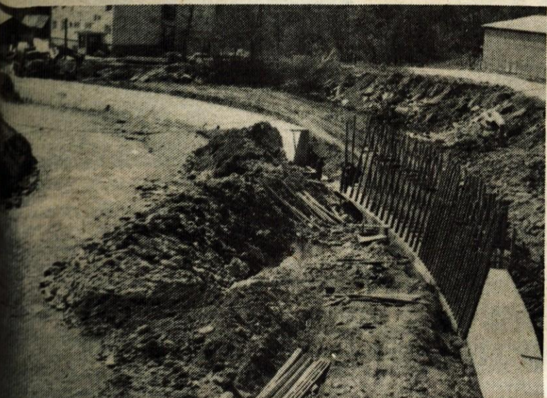
Sanacija Trziške Bistrice — Območna vodna skupnost Gorenjske je odločila, da da ob Trziški Bistrici zgraditi 160 metrov opornih stien, ki bodo muhasti reki preprečili spodkopavanje obrežja. Do tega prihajalo večkrat, najhuje pa je bilo po lanskem januarskem povodnji. Gradnjo financira skupnost s pomočjo Metalkine temeljne organizacije Triglav in Gradbinca, ki bosta po sanaciji pridobila tudi dodatnih uporabnih površin zemlje. (H. J.) — Foto: F. Perdan
