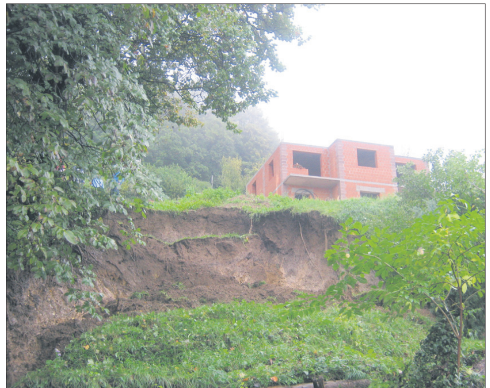
Eden od desetih plazov v občini Štore ogroža gradbišče stanovanjske hiše na širšem območju Svetine. Ga bodo folije rešile?
