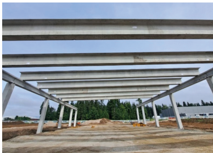
Slika 7. Glavna nosilna konstrukcija skladiščnega dela objekta.
