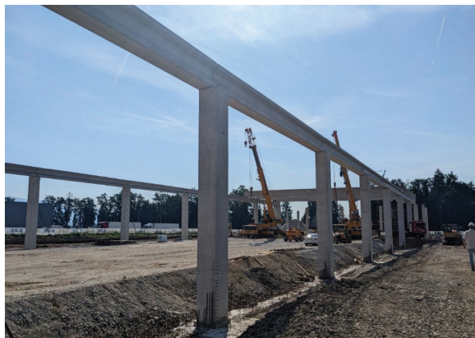
Slika 5. Postavitev stebrov in »wing« nosilcev.
