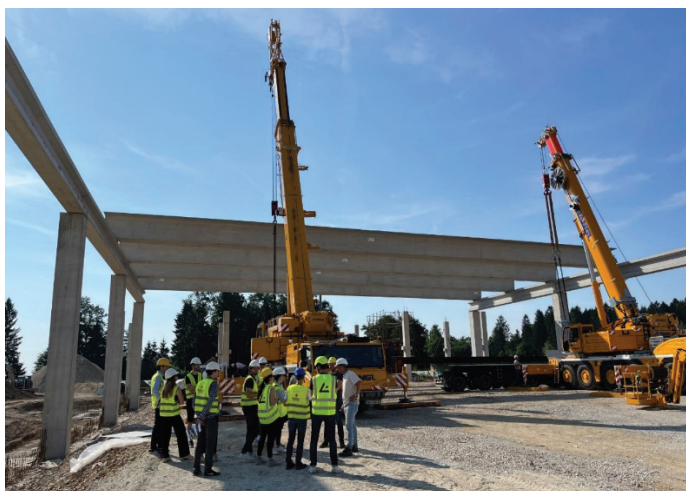
Slika 6. Montaža »wing« nosilcev s pomočjo dveh avtodvigal.
