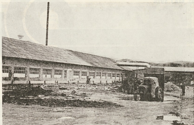
Začetek rekonstrukcije — gradbena dela v TP Stari trg
