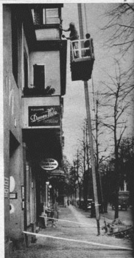
Ein Einzelmast als Maurergerüst. Diese an dem Mast bewegliche Plattform, auf der zwei Mann Platz haben, wird neuerdings besonders für Ausbesserungsarbeiten an Hausfronten gern verwandt Photothef
