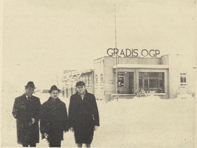
»Dežurni oficirji« med novoletnimi prazniki v obratu gradbenih polizdelkov
