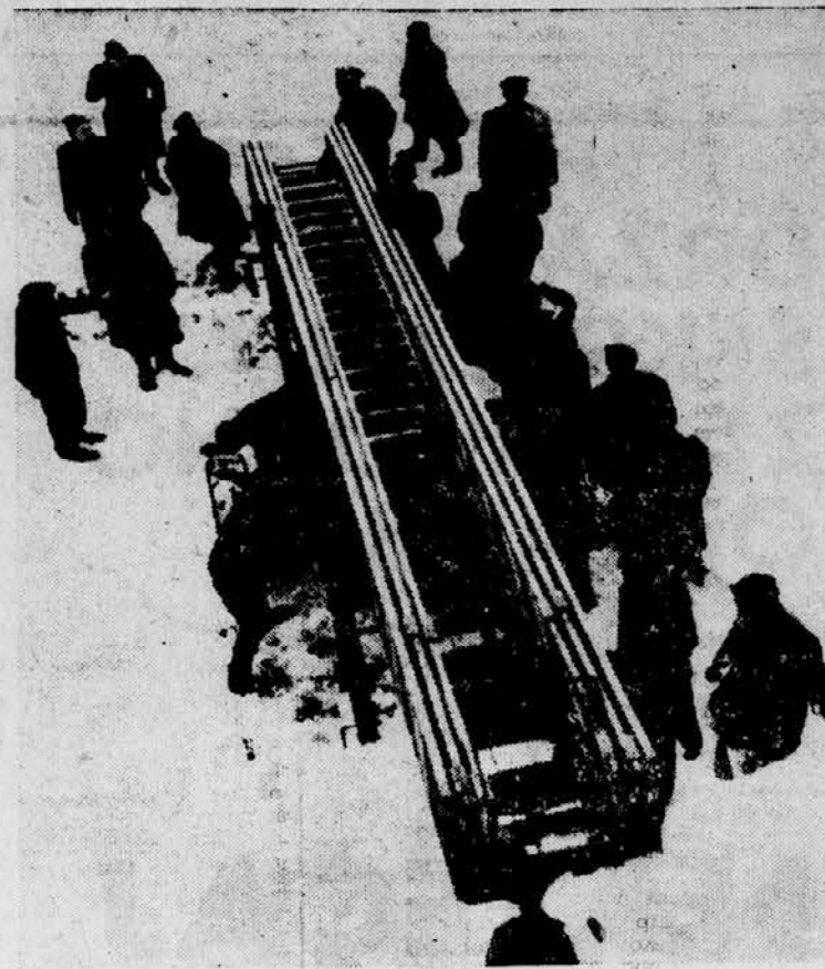
PREVEČ SNEGA ZA TIVOJSKO DVORANO — Na Novega leta dan je bilo okoli dvorane Tivoli v Ljubljani pravo »obedno« stanje. Ker bi lahko zapadli sneg zrušil streho, so poklicali na pomoč gasilce, miličnike in vojske, ki so nevarnost odstranili. Foto: E. Selhaus
