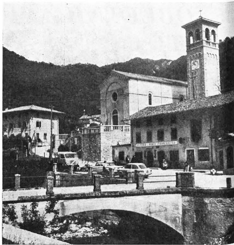
Canal di Grivò appartiene al pedemonte. E' circondato in parte da graziosi monti, che sembrano posti lì a sua difesa, ed è lambito dalle acque del Grivò che quando tracimano creano non solo spavento ma anche gravissimi danni
