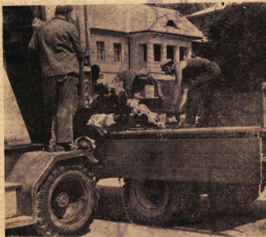
Nakladanje jamskih stojk za Madžarsko v STT. Še ta mesec bodo poslali na Madžarsko 4000 teh iskanih jamskih opornikov
