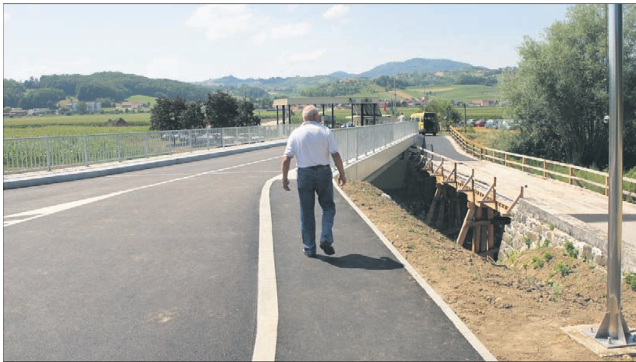
Gradnja novega betonskega mostu in obnova starega lesenega sta stali okoli 400 tisoč evrov. Državi sta si stroške razdelili.
