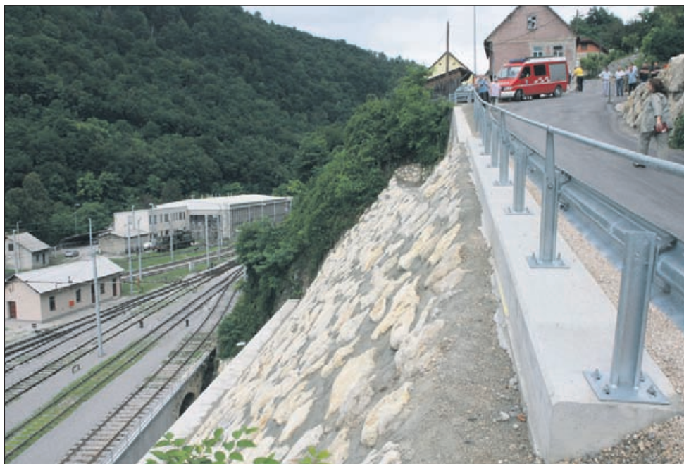
Obnova plazu in ceste se je začela septembra 2011.
