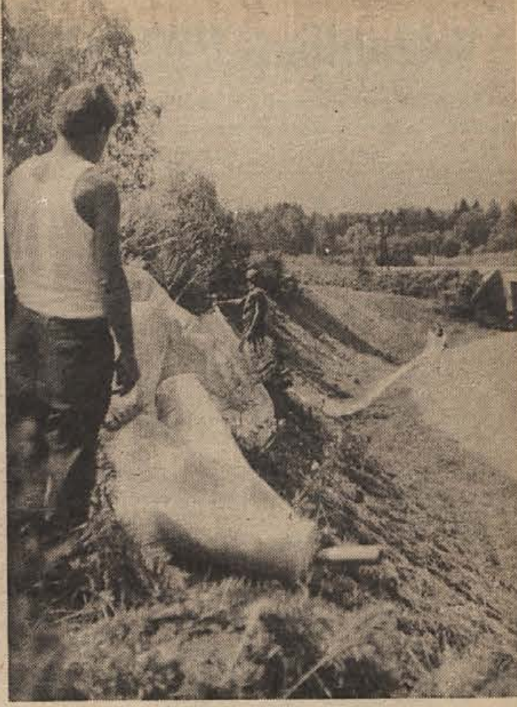
„Kaj bo pa to?“ ugibajo ljudje, ki se peljejo čez Gorjance in vidijo, da delavci Cestnega podjetja na nekaterih pobočjih ob cesti napolnjujejo na desetine metrov lepe zelene mreže. Novost je le novi način zavarovanja komaj posajene trave. (Foto: Ria Bačar)
