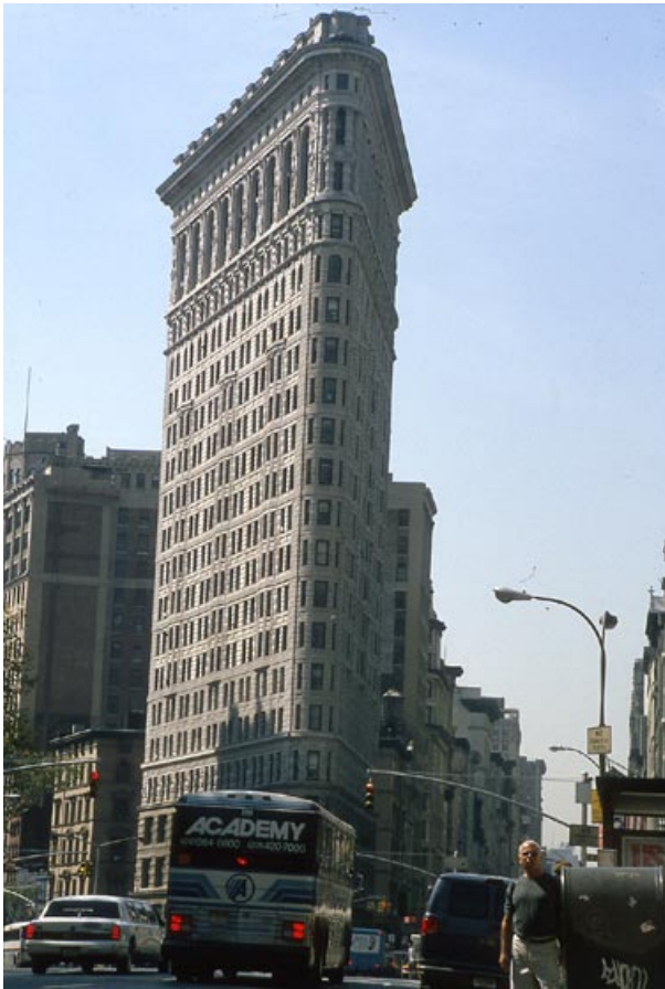
■ Slika 5. Jeklena konstrukcija v kamnu - New York, Flatiron Building. Na videz kamnita zgradba ima kovinsko jedro, kamen je le obloga.
