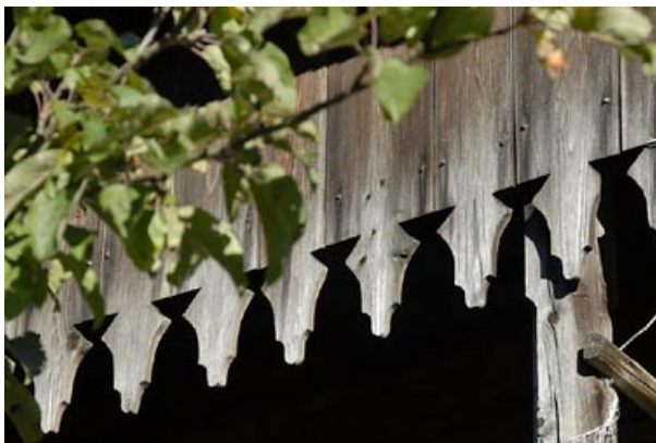
■ Slika 9. Kapljica: ne glede na obliko manjša spodnjo površino elementa. Izgleda dekoracija, a je značilna konstrukcijska rešitev gospodarnosti in daljša življenjsko dobo. V najbolj preprostih rešitvah je zarezan trikotnik, potem res 'kapljica', z novimi tehničnimi rešitvami so oblike različne, bližje dekoraciji, a še vedno povsem konstruktivnega izvora in delovanja.
