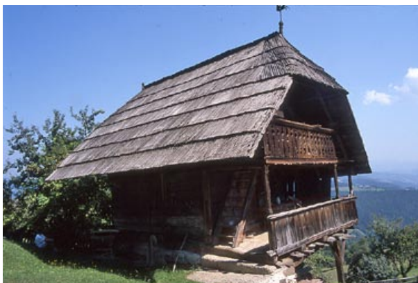
■ Slika 8: Koroških škodel potrebujemo za povprečno veliko streho šestdeset tisoč: in če stane vsaka pol evra ... Gorenjski način uporablja pamet v načelu: preklap. V izvedbi je bistveno manj zahteven, poenostavljen. Na sliki je škodlasta streha na Strojni (Koroška) 1980.
