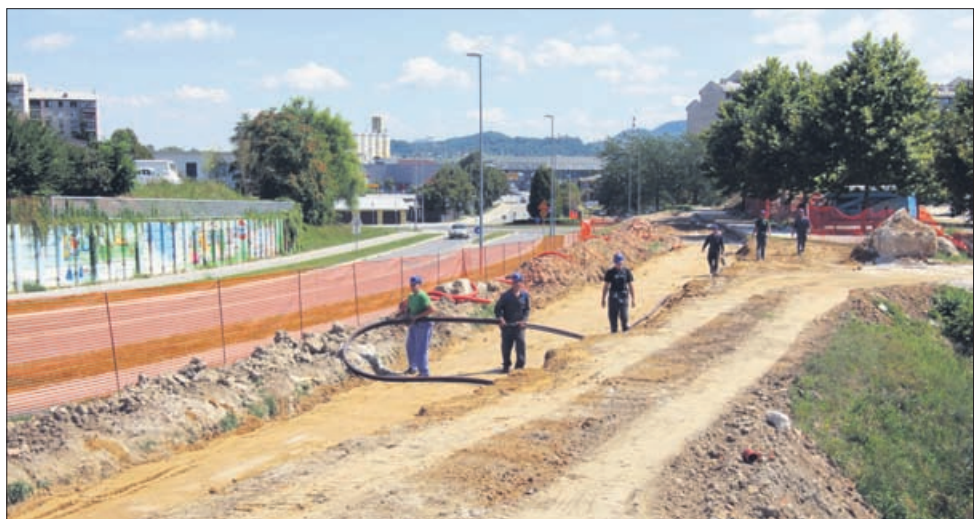
Nov vročevod s Hudinje proti Novi vasi bo povezal vzhodno in zahodno omrežje daljinskega ogrevanja v mestu.
