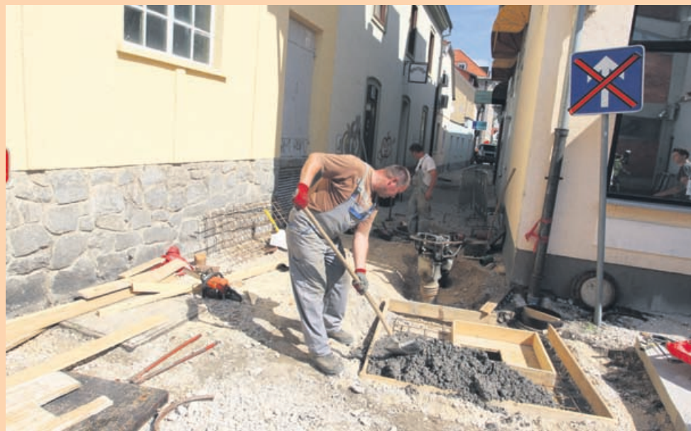
V petek so delavci betonirali jaške ob vstopu v Ozko ulico, te dni naj bi cestišče znova dobilo tudi asfaltno prevleko.
