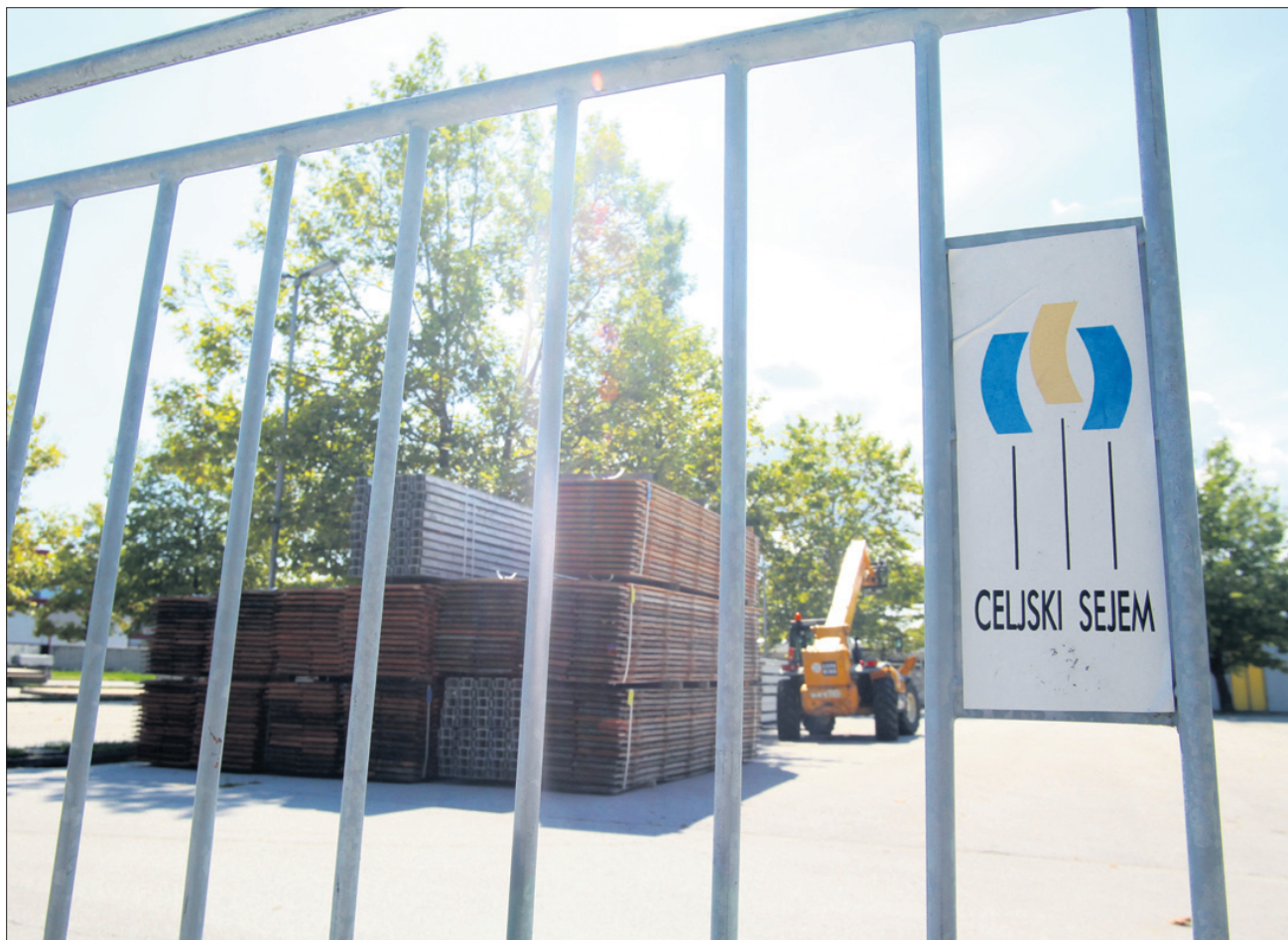
Te dni so na zunanjih površinah sejma začeli postavljati montažne dvorane.
