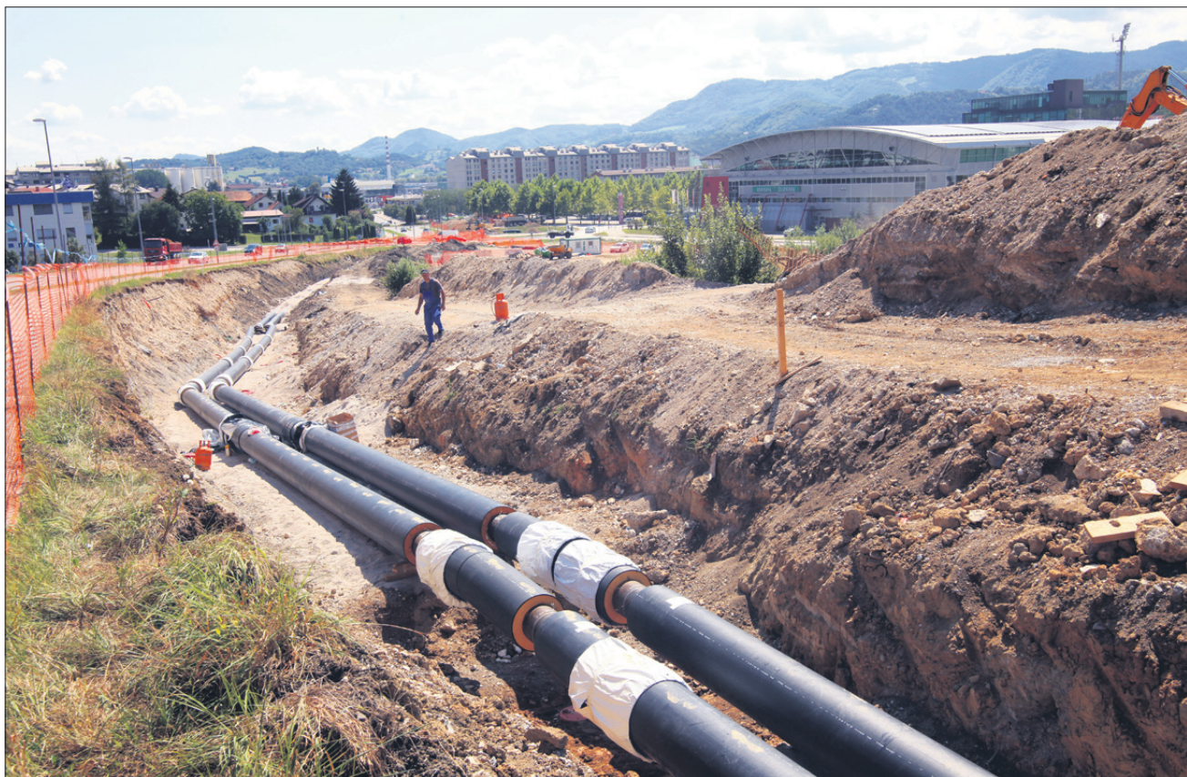
Na tem predelu ob dvorani Zlatorog, kjer je v neposredni bližini predvidena gradnja hotela, so morali zaradi tega, ker hotel ter oporni zid do ceste še nista zgrajena, nekoliko prilagoditi tudi traso vročevoda.
