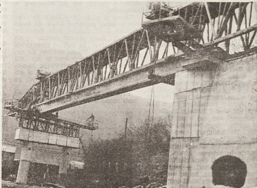
Montaža vzdolžnih nosilcev v I. polju
