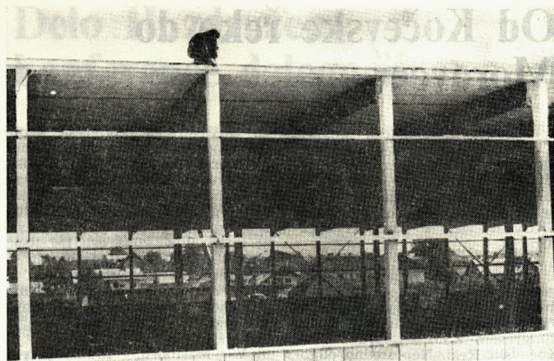
Montaža jeklene konstrukcije je nevarno delo
