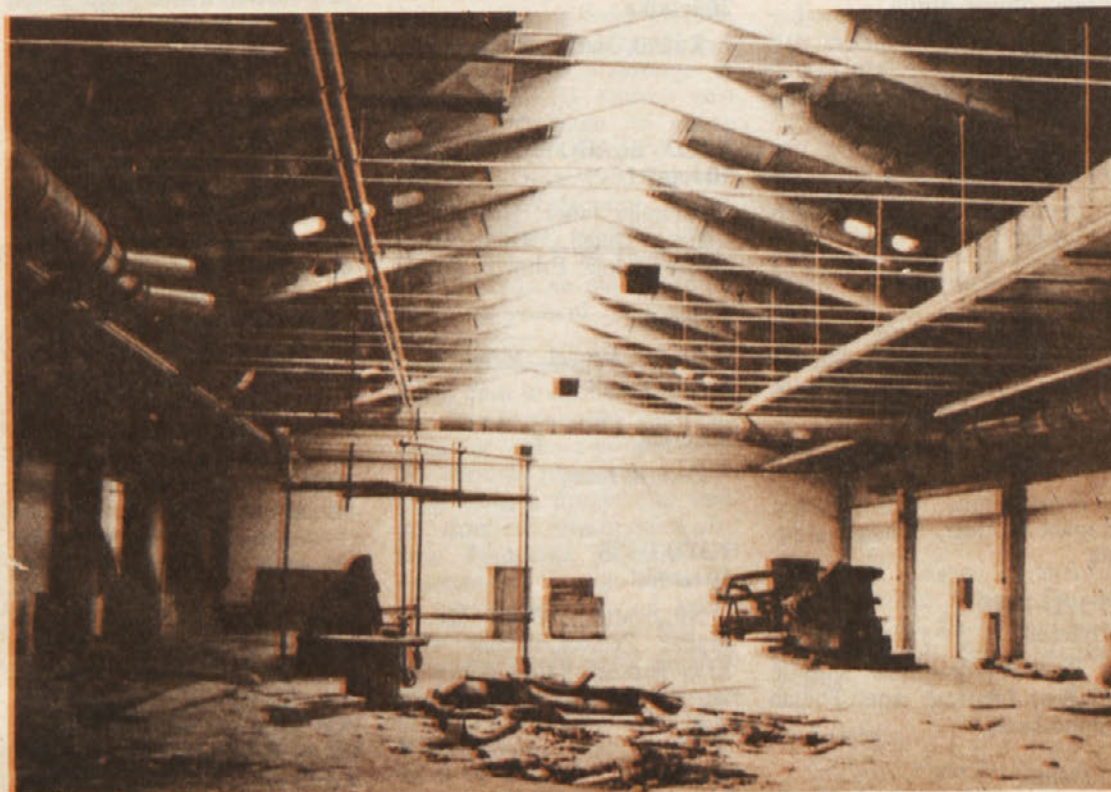
TOZD TSP — notranjost novega objekta med zaključnimi deli
