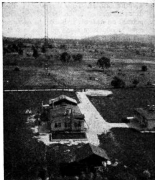
Poslopje sedanje radijske postaje v Domžalah. Novo je v gradnji.
