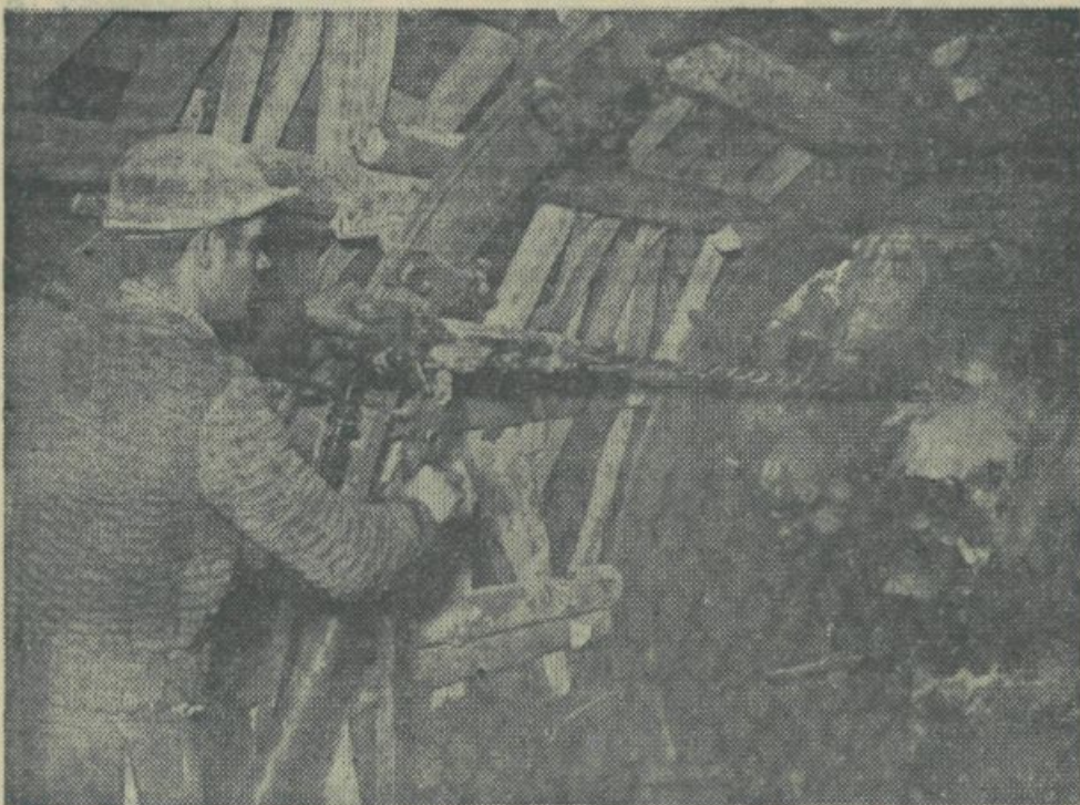
Napredek v izvozni progi. Ciklus dela: vrtanje
