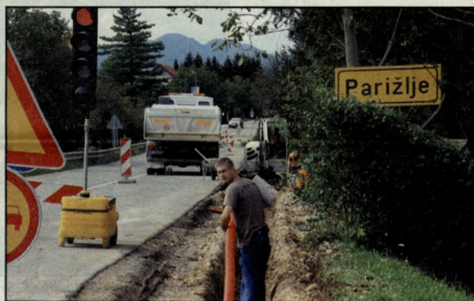
Gradnja pločnika v Parižljah
