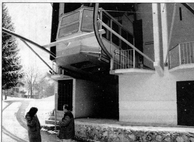
Pokojna delavca sta brez potrebnega varovanja demontirala varovalno vrvo čeljust in po vsej verjetnosti še popustila nosilno vrvo čeljust (foto: EMS)
