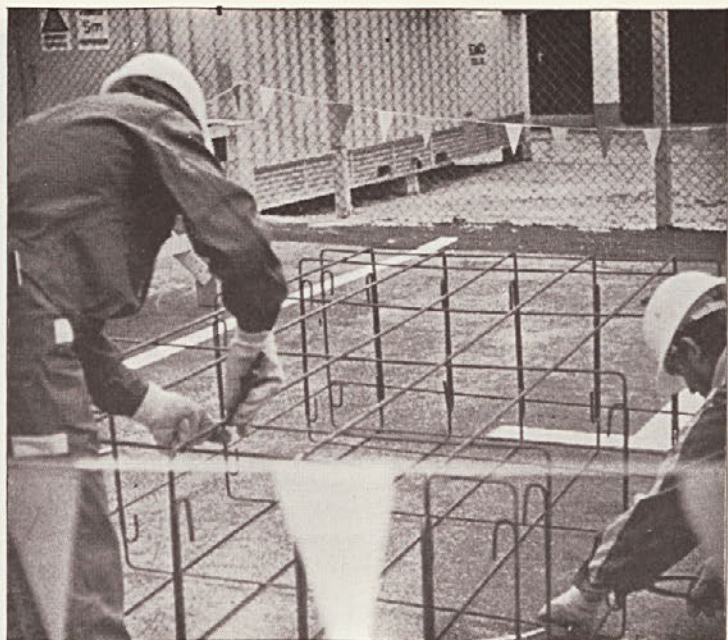
Železokrivci pri vezavi konstrukcije
