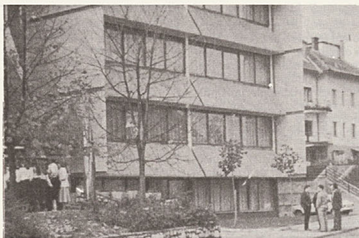
Za občinski praznik odprt prizidek Ekonomsko-administrativnega centra. Gradbena dela je opravil TOZD gradbeni sektor Novo mesto (foto: Borsan)
