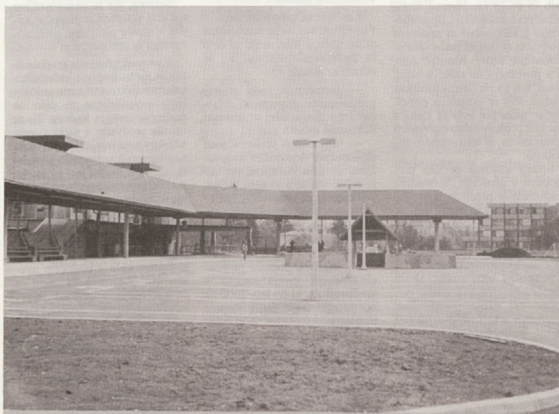
Vhod na novo avtobusno postajo z Roške ceste.
