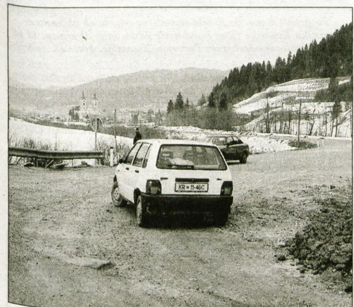
Začasna obvoznica na cesti Žiri - Logatec ima že izgled sodobne regionalne ceste, manjka le asfalt. Po izteku svoje začasnosti naj bi bil to del nove žirovske obvoznice in hkrati dovoz na območje Maršaka.
