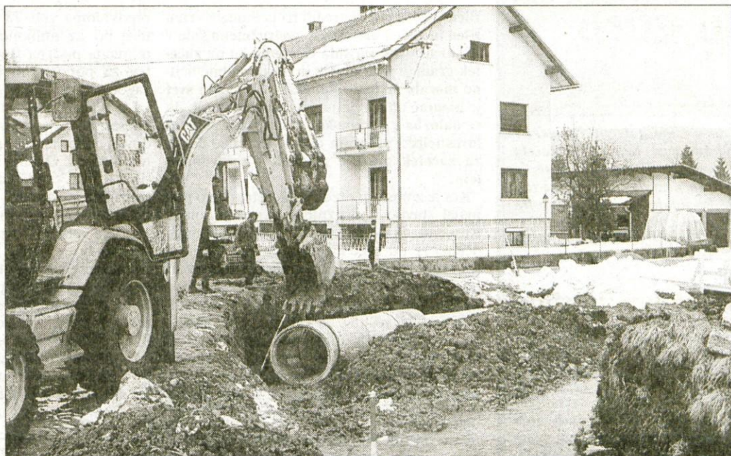
V torek so delavci Cestnega podjetja Nova Gorica podrli stari most in že pripravljajo gradnjo novega.
