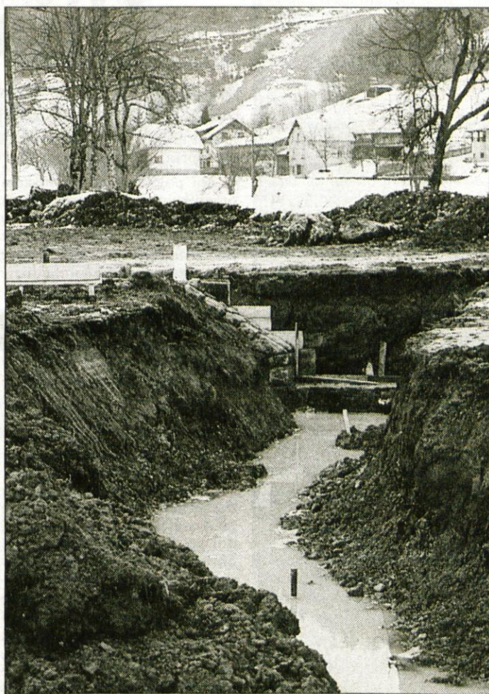
Podjetje za urejanje hudournikov je že v decembru začelo obsežna zemeljska dela na urejevanju struge Osojnice in izgradnji razbremenilnega kanala. Občina bo prispevala kamenje za oblaganje.
