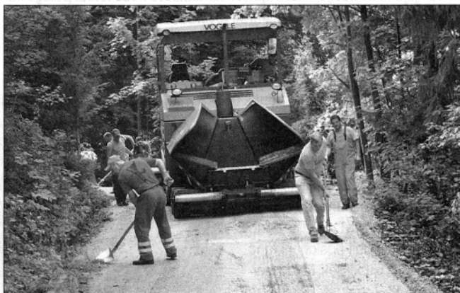
Pripravljanje podlage za asfalt na cesti Zavodice-Čreta
