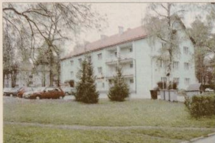
Občinska in poslovno - stanovanjska zgradba je edini svetel objekt v blokovskem naselju
