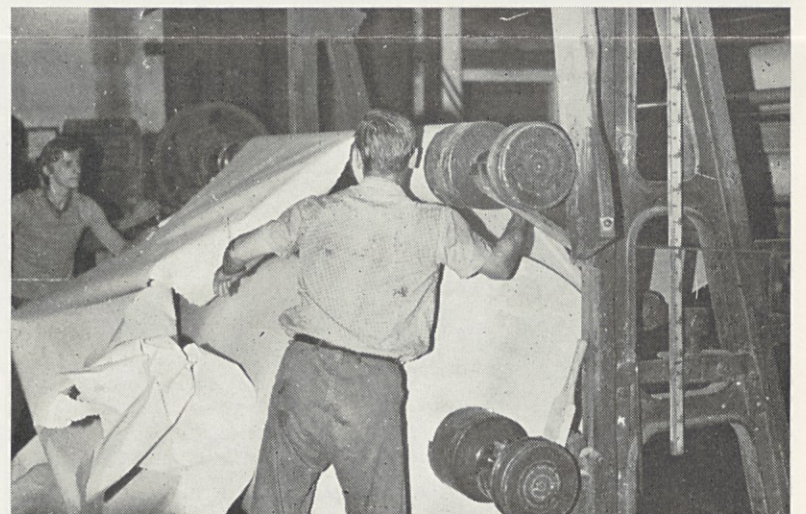
Menjava zvitka na stroju zahteva obilico ročnosti. Na sliki: menjava pri II. PS
