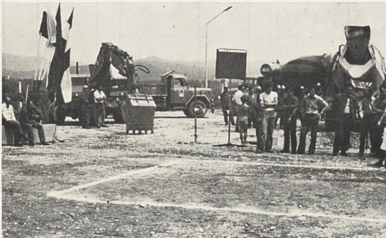
Gradbeni stroji so pripravljani
