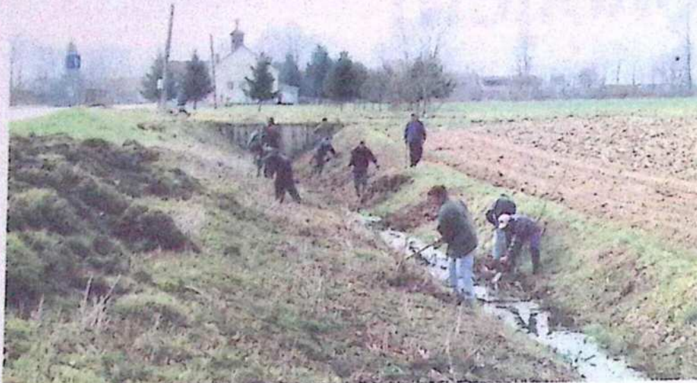
Lani so lastniki zemljišč ob melioracijskih jarkih sami posekali drevje, prej pa so se lotili še ene prostovoljne delovne akcije in odstranili panje. Melioracijski jarki so zdaj urejeni in naredi za novo košnjo.
