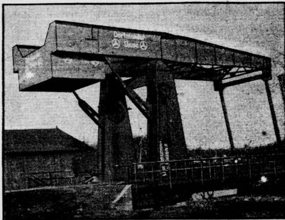
V Swinemündeju so izročili prometni dvigalni most, ki temelji na principu protivne težine. Most odvarja ladjam gladek prevoz skozi kanal
