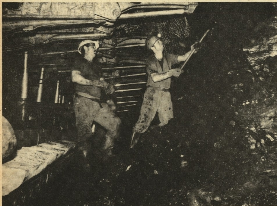
Sreto Dujaković in Ivan Matko izdelujeta strop na odkopnem čelu v jami Rudnika Trbovlje.
