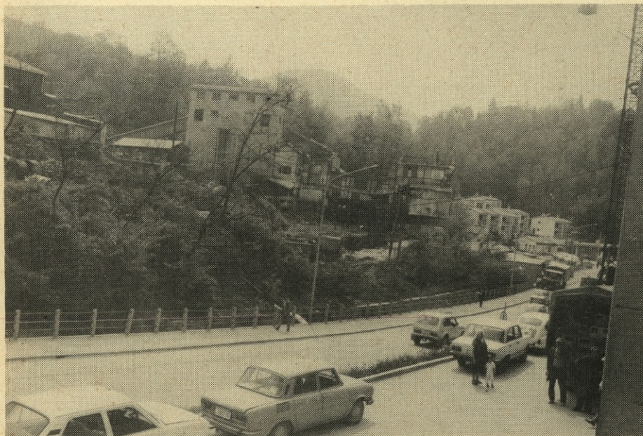
Objekte stare separacije v Hrastniku postopoma odstranjujejo po lanskoletnem požaru. Na tem mestu bodo postavili novo gradbo za rudniške delavnice. (Foto: A. Bregant)
