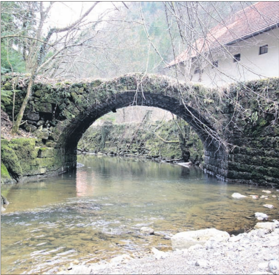
V okviru celotne oživitve kartuzije Jurklošter je tudi obnova mostu. (Foto: TimE)
