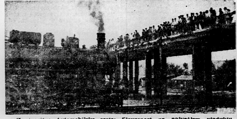
Z otvoritve Avtomobilske ceste: Slovesnost na največjem viaduktu, pri Novski, dolgem 155 m, ki ga podpira 14 vrst vitkih betonskih stebrov
