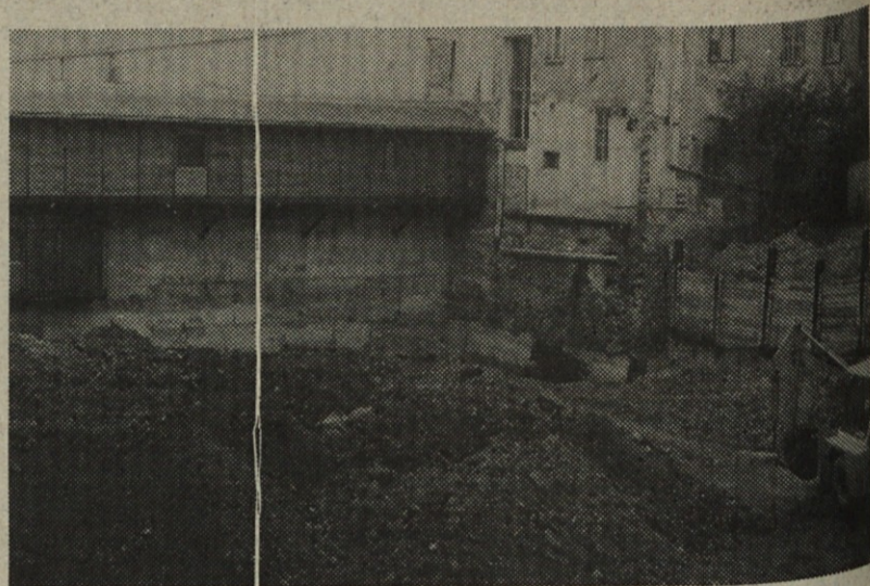
Izkop gradbene jame za obnovo SNG v Mariboru
