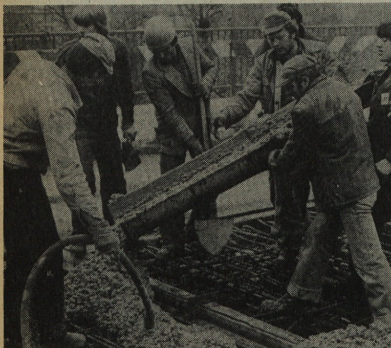
Betoniiranje ojačanih diletacij na črnuškem mostu
