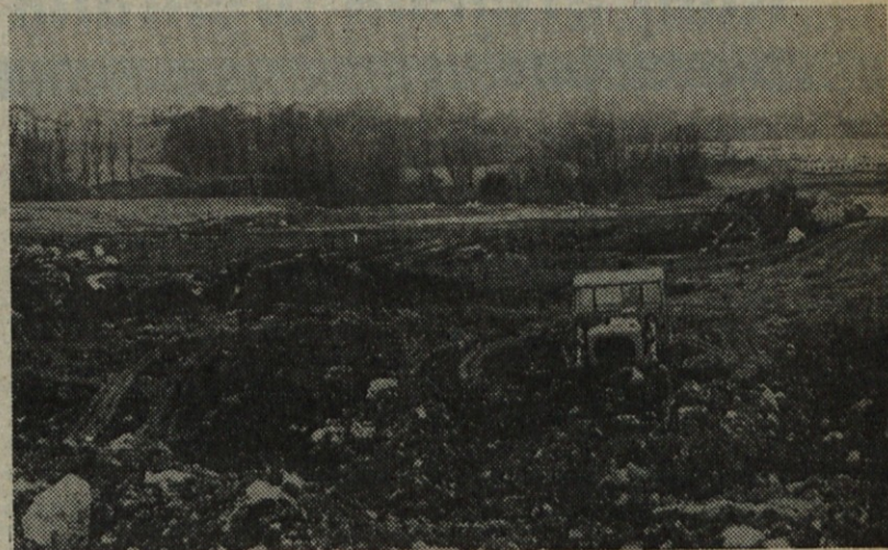
Prva dela za tovarno prikolic (I. faza) so se že začela
