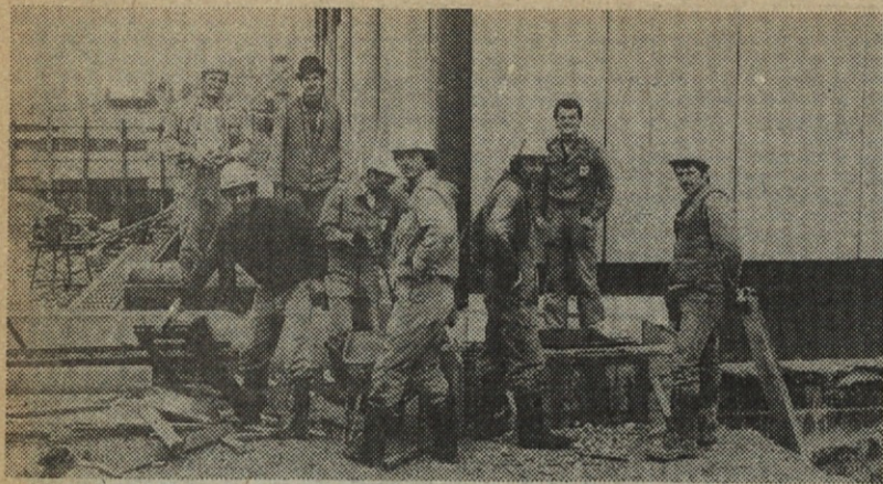
Skupina delavcev na gradbišču poslovnega centra Mercatorja
