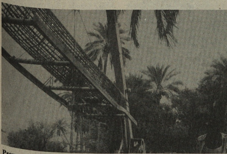
Prenos armaturnih košev za pilote
