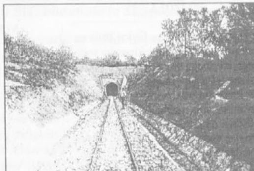
Zahodna stran ob izgradnji
