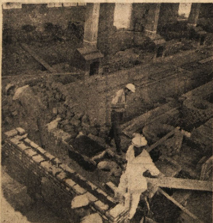
Zidarji gradbenega podjetja »Pionir« pod strokovnim vodstvom tehnika zagrebške »Vatrotehne« obidavajo novo Hofmannovo peč. Čez nekaj časa bodo prišle iz nje prve žgane opeke
