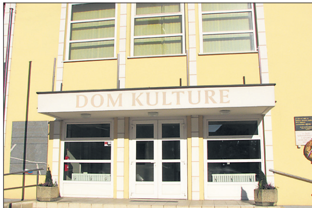
V Lenartu si bodo kljub zapletom prizadevali še letos končati začetno rekonstrukcijo kulturnega doma.
