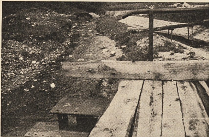
Stara in nova struga potoka Kotredežca, ki jo regulirajo Zasavski premogovniki v celoti iz svojih sredstev. Foto: Inž. Tone Bregant
