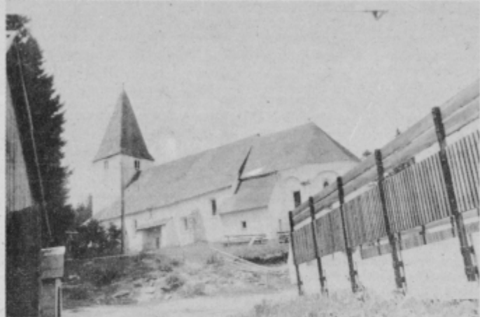
Na zunaj mogočno zgradbo, cerkev Treh kraljev znotraj že močno načenja zob časa.
