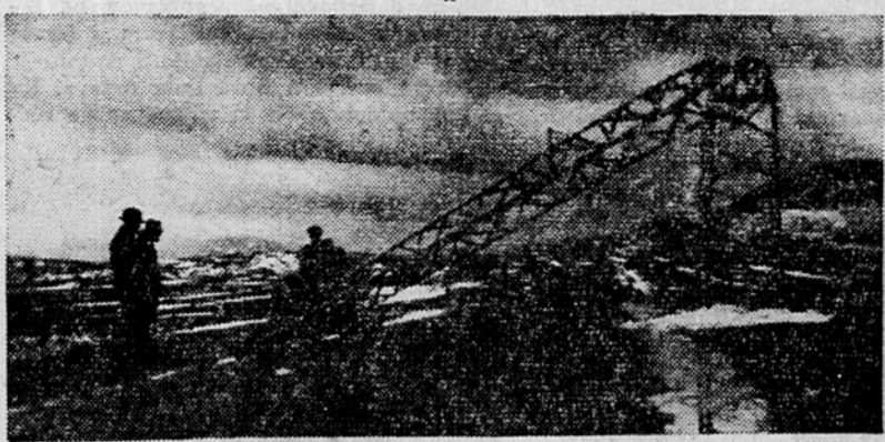
Tudi močne železne transformatorje včasih zviže močna burja
