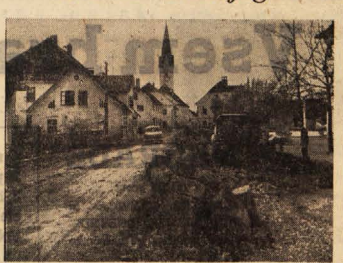
Glavna cesta skozi Trebnje je prekopana. Z občinskimi sredstvi nameravajo še pred zimo dokončati kanalizacijo; v ta namen kopljejo glavni kanal in polagajo cevi.
