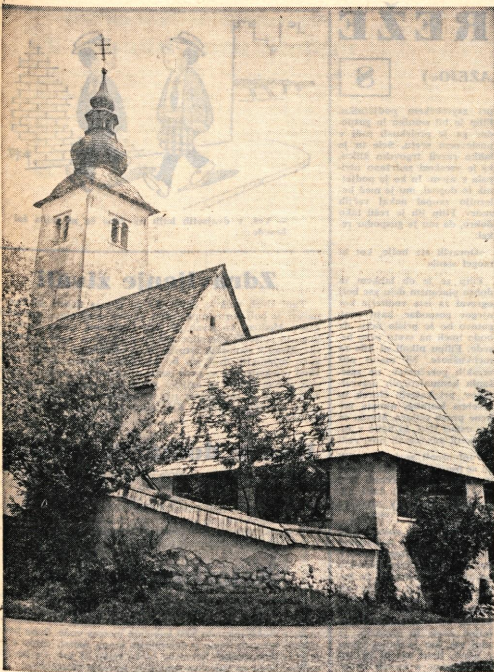
Zavod za spomeniško varstvo je na predlog turističnega društva Bohinj odobril del denarja za prekritje cerkvice Sv. Janeza v Bohinju. Nekaj sredstev sta prispevala tudi občinska skupščina in TD Bohinj. Obnovljena streha bo krita s skodlami, ki so jih pripeljali iz Dražgoš. — Foto: F. Perdan
