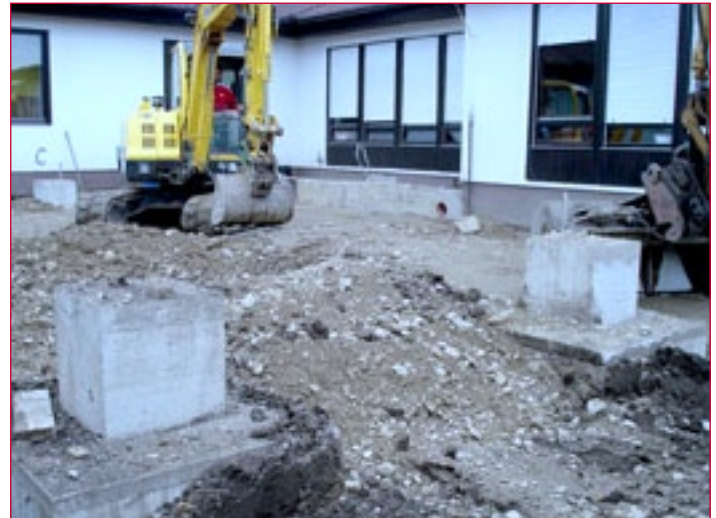
Gradbena dela na lokaciji vrtca – enota Marjetica, Med vrti 11.
