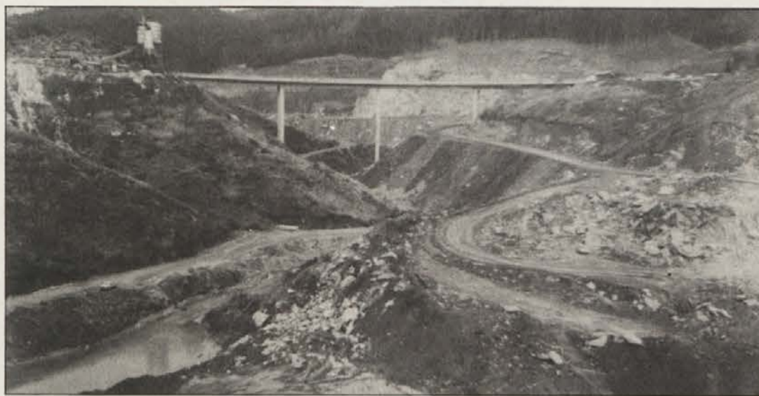
Most na cesti, ki pelje preko prehoda Soboth, bo čez leto dni 25 metrov globoko pod gladino zbirnega jezera za elektrarno na Golici.
