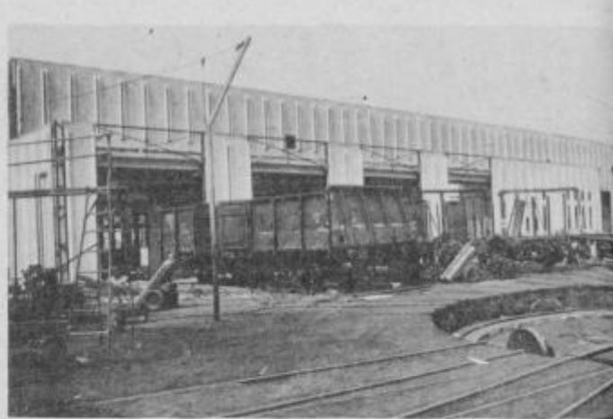
Nova tovarniška dvorana bo že prihodnji mesec pripravljena za proizvodnjo
