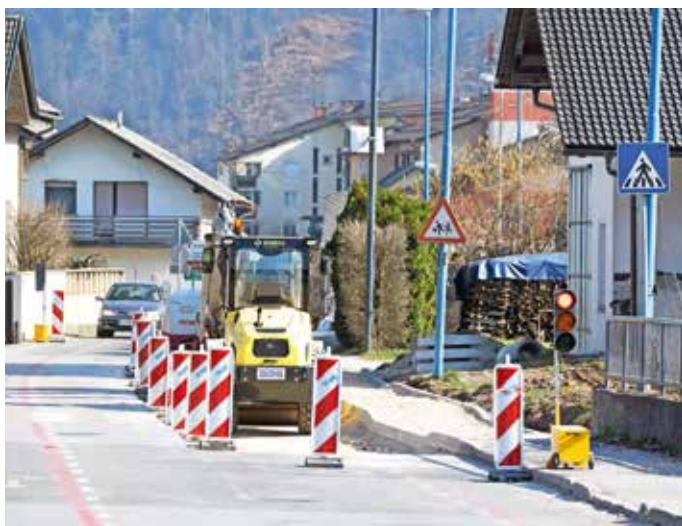
V času gradnje je na Škofjeloški cesti vzpostavljena polovična zapora. / Foto: Peter Košenina
