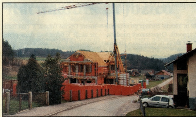
Pogled na novo šolo
