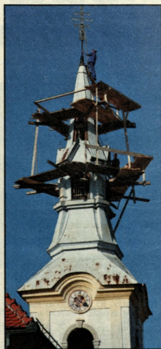
Pri obnovi zvonika
