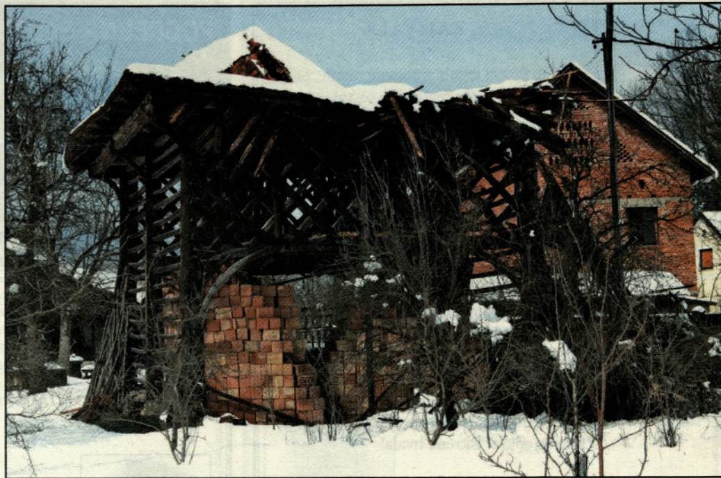
Pod težo snega je popustila streha na kozolcu na Polzeli.
