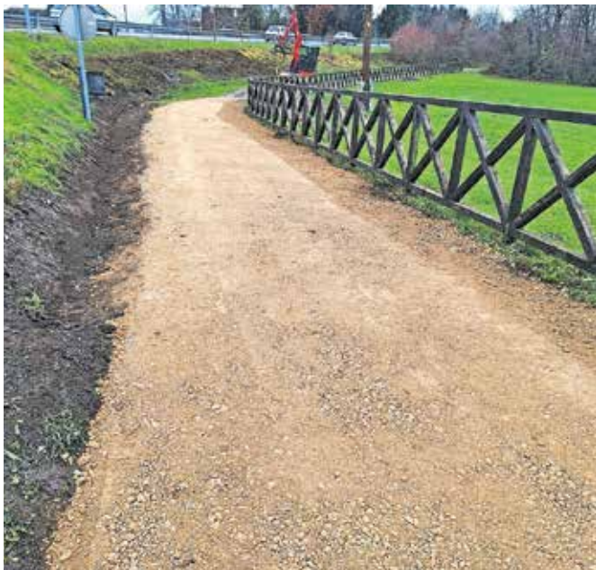
Sanacija dela pešpoti ob Kamniški Bistrici / FOTO: OBČINA KAMNIK
