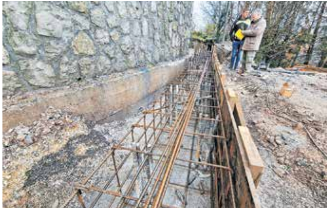
Sanacijska dela na Perovem / FOTO: OBČINA KAMNIK
