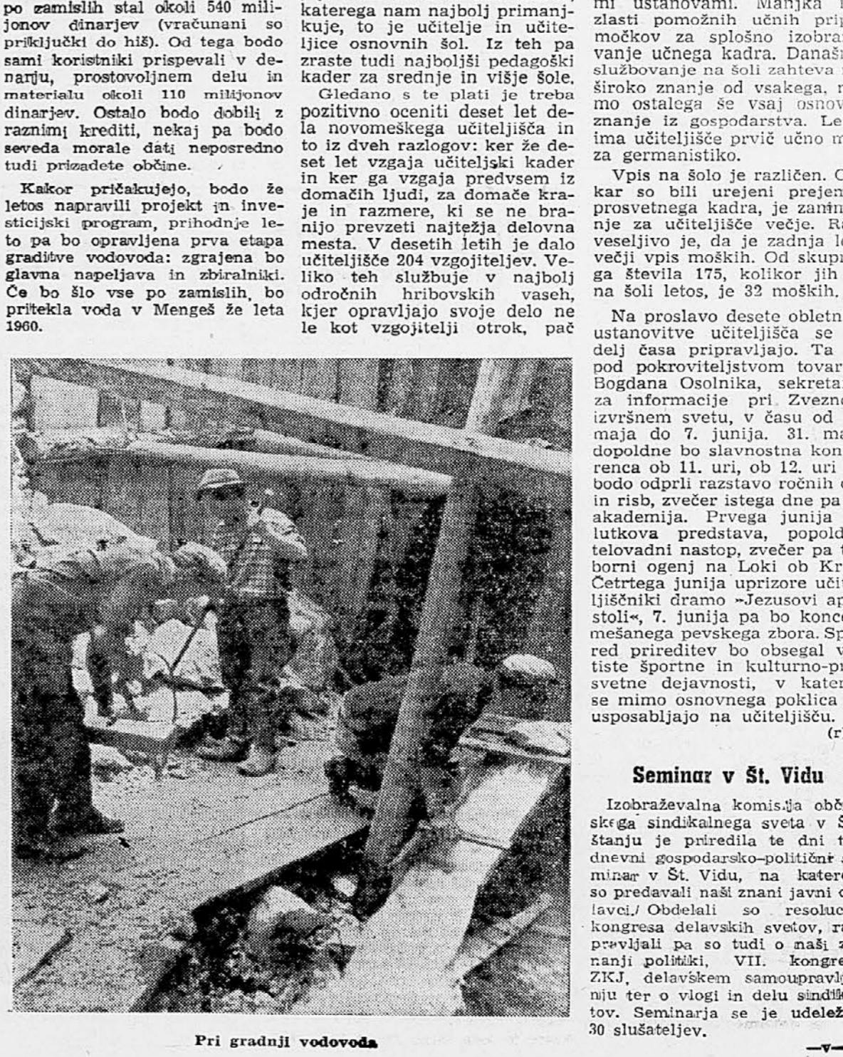
Pri gradnji vodovoda
