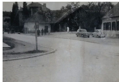
Križišče ob severnem delu jedra naselja, kjer je predvidena izgradnja hotela.
