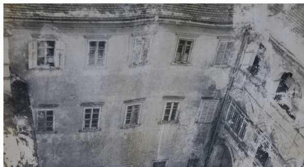
Dvorišče gradu, južni trakt in del zahodnega.
