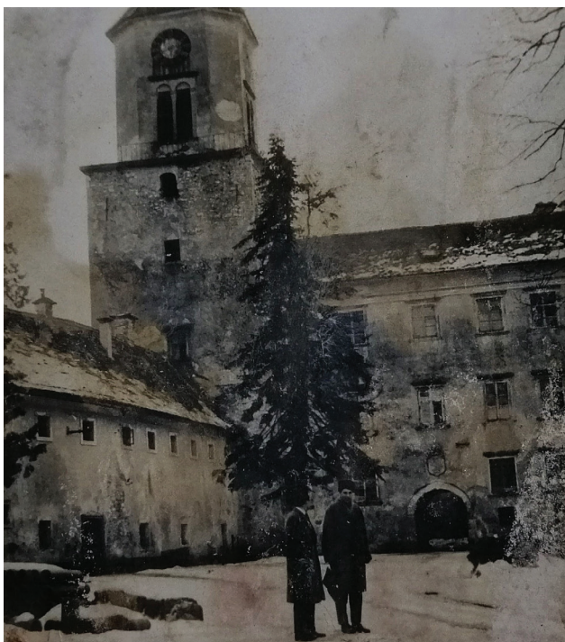
Ormoški grad, vhod, stolp s teraso in severni prizidek, ki je že porušen.
