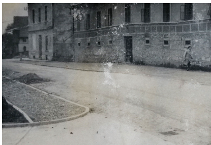
Cesta mimo črpalke, ki vodi na železniško postajo in Hrvaško.
