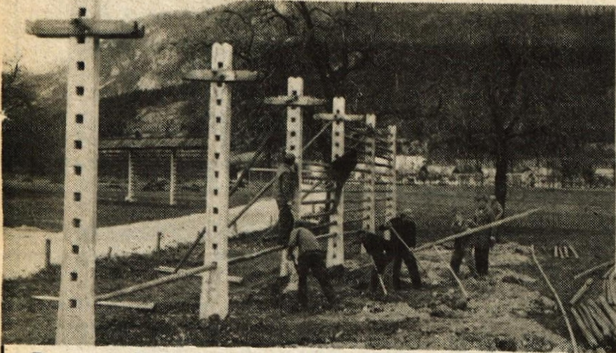
Begunje – Prejšnji petek se je skupina Elanovih delavcev trudila z zanje dokaj nenavadnim delom: v bližini tovarne so postavljali kozolec. Elan se namreč širi proti severu in ima tam že dalj časa po urbaniščenem načrtu rezervat za svoje nove investicije. Nova zemljišča potrebuje za nova skladišča lesa in telovadnega orodja. Pa je na tem zemljišču stal tudi velik Stavarjev kozolec, ki ga je bilo po pogodbi treba prestaviti na drugo Stavarjevo zemljišče. Pogodba je pogodba in treba jo je spoštovati. Zato so Elanovi delavci zavihali rokave in se ga lotili. Pa jim je šlo delo kar dobro od rok. – Foto: D. Dolenc
