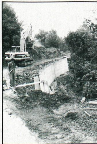
Slika 2: Sanacija ceste - Židovnik-Medvedje brdo
