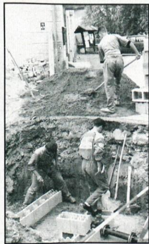
Slika 4: Izgradnja vodovoda Rovte
